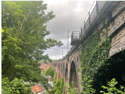
Le viaduc de Barentin, vu de la gare
